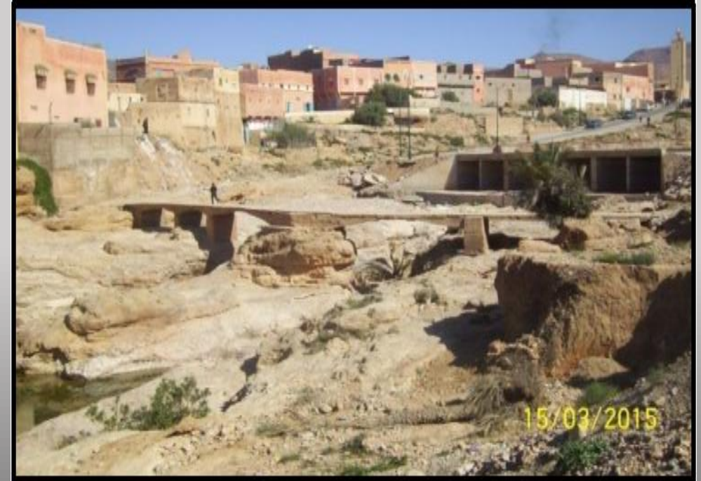
Photographie I-8 : L'extension de l'habitat à côté du lit de l'oued Ifrane à Ifrane Anti-Atlas central (source : ATBIR, 2019)
