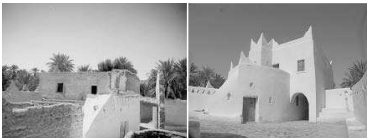
Activités typiques de réhabilitation : Ecoles Tylawaan avant (à gauche) et après sa réhabilitation (droite).
