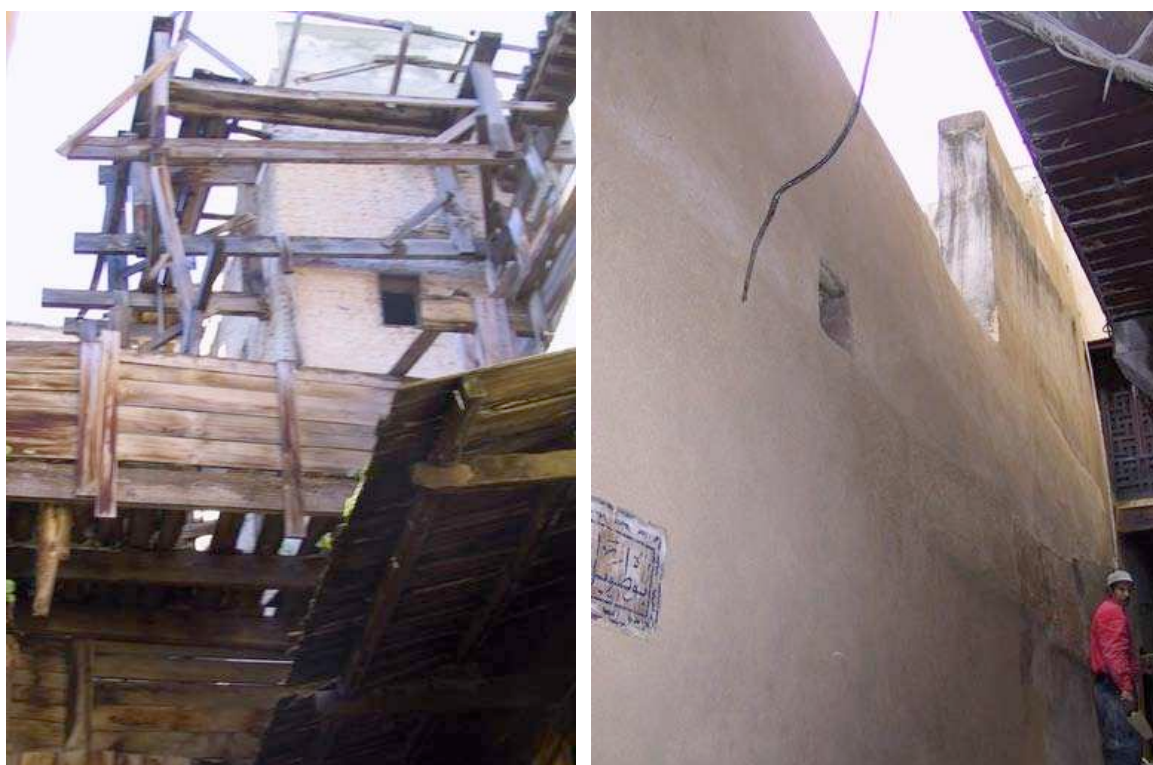
Travaux de consolidation et réhabilitation du tissu résidentiel
