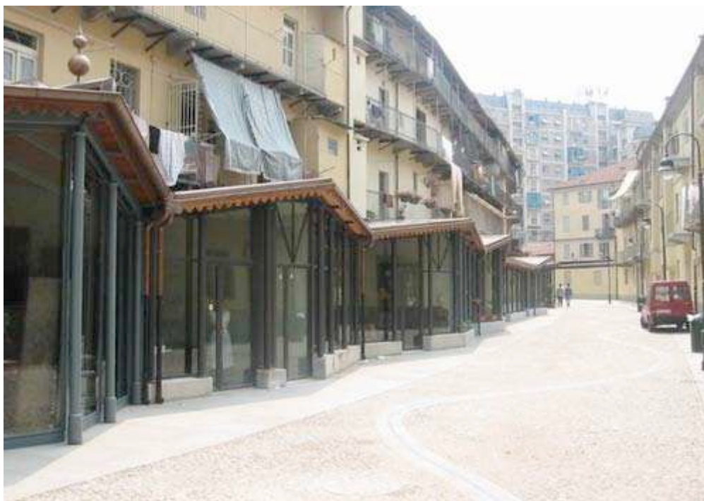
La réhabilitation d'une rue du quartier
