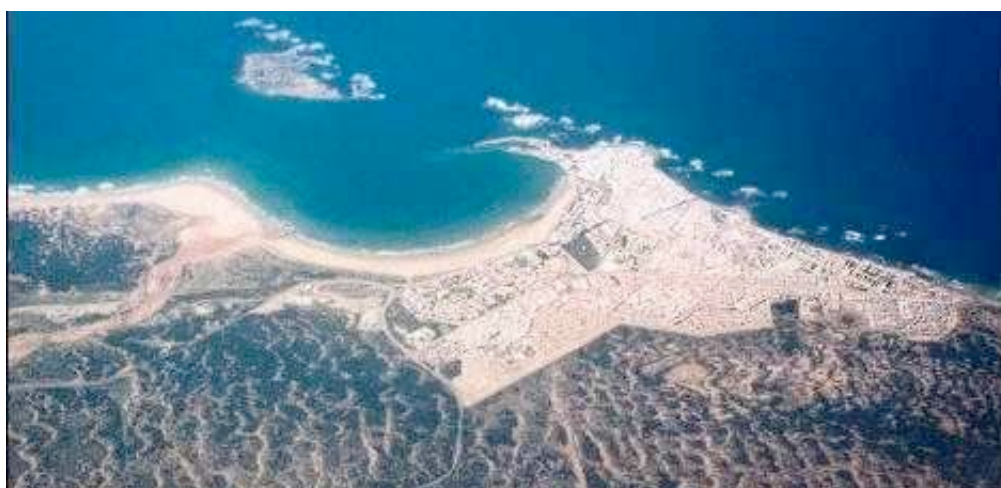
Le site d'Essaouira, entre l'Océan et les dunes, menacées par les lotissements
