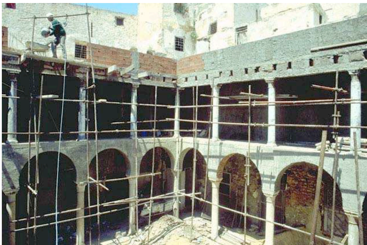
La réhabilitation d'un oukala
